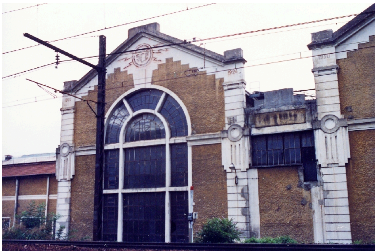
Pignon ouest de la halle Z
