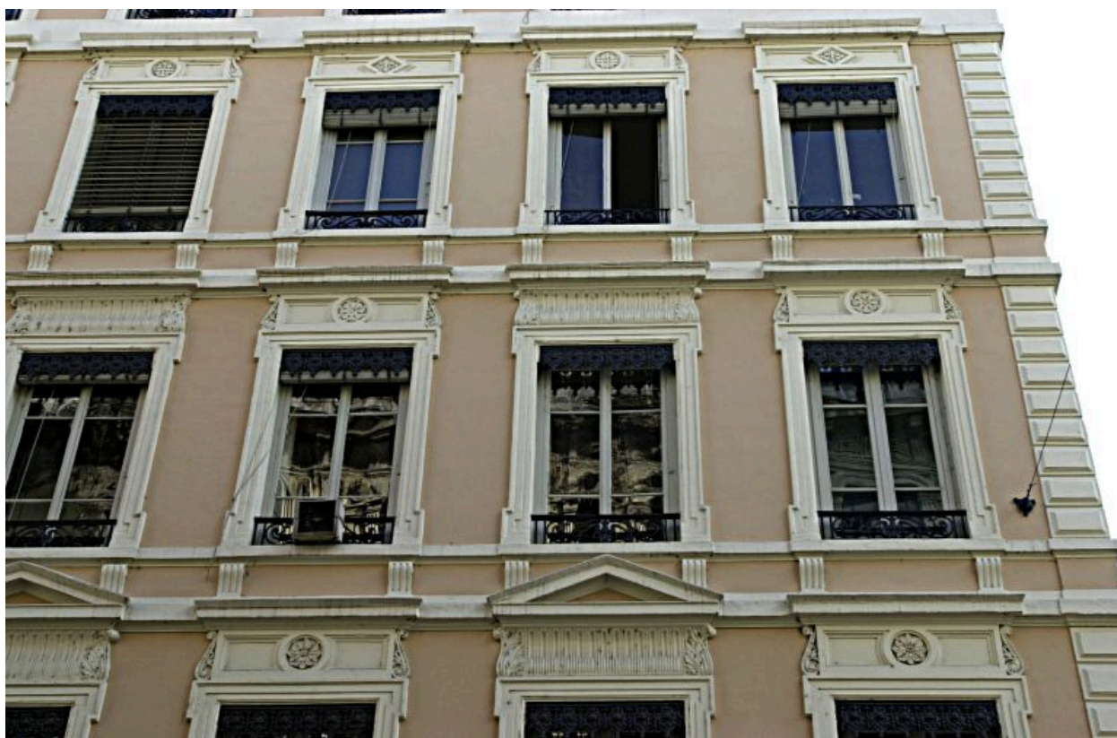
Façade principale, détail du 2e étage
