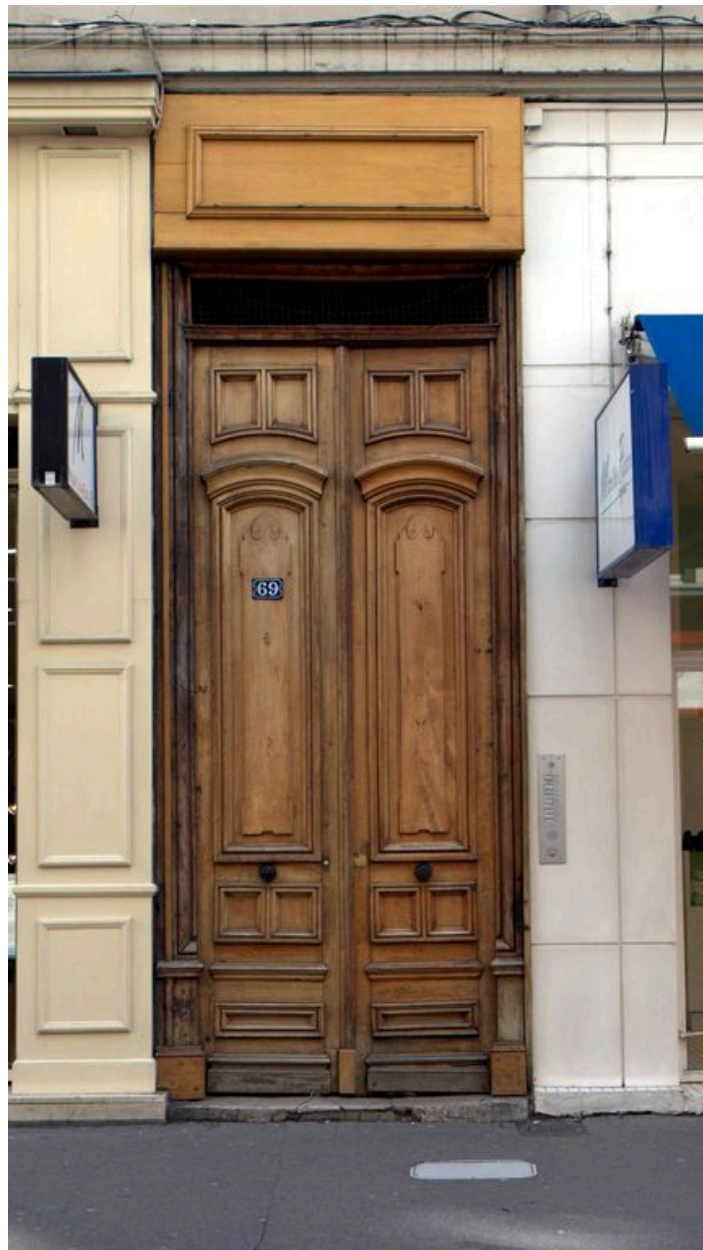
Elévation antérieure, détail de la porte
