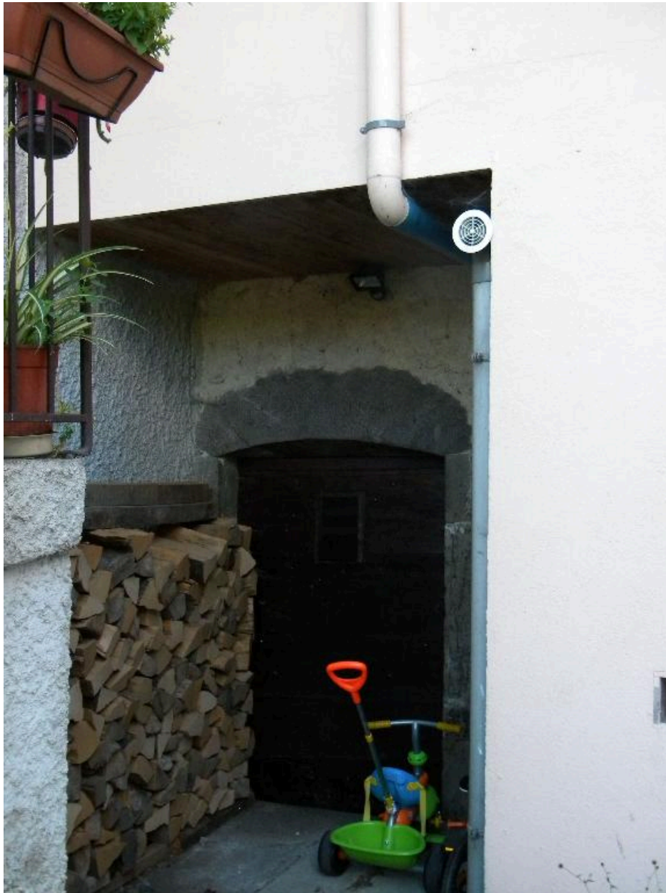
Vue d'une entrée de cave avec linteau délardé en façade est.
