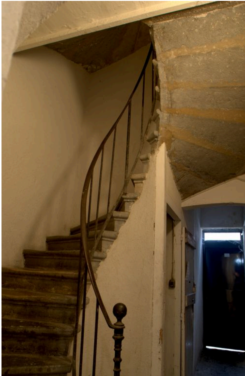
Vue de l'escalier suspendu
