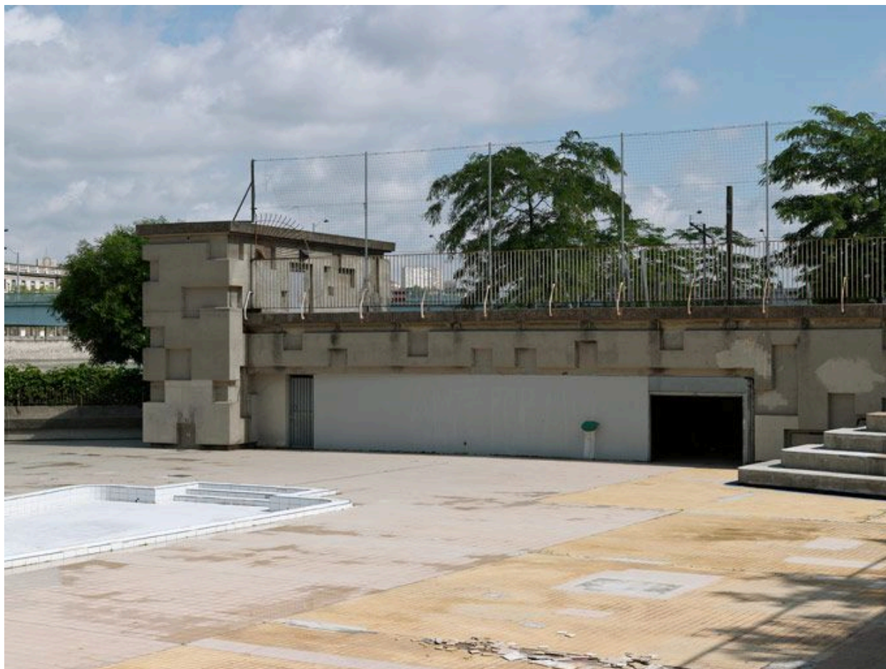
Vue du local technique, situé au nord (état juin 2012).
