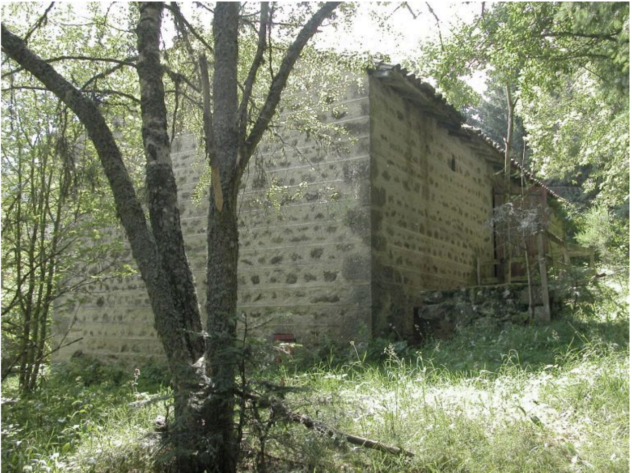
Vue d'ensemble de trois quarts depuis le sud-ouest.
