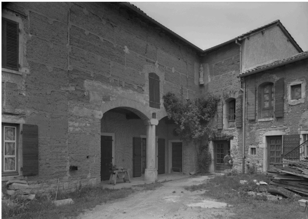
Maison de type VI, Saint-Didier-de-Formans, chemin Charbonnet : ancien corps de passage et corps de logis, élévations sur cour.
