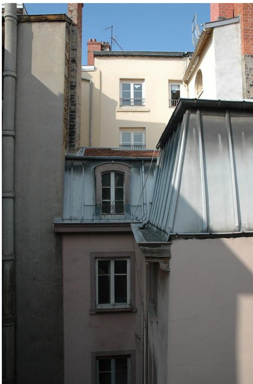
Elévations sur cour : l'étage de comble et la cage d'escalier
