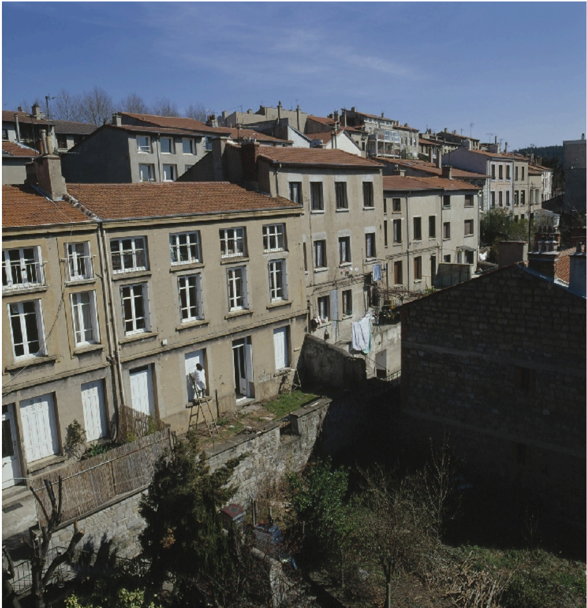
Façade principale avec vue partielle du 78 rue Royet et de l'implantation en milieu de parcelle
