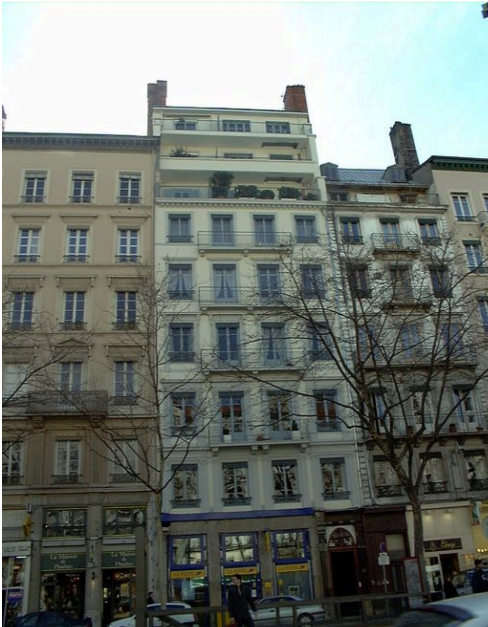
Façade sur rue, vue générale
