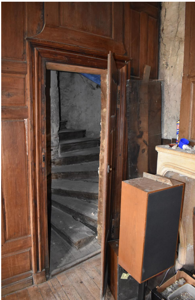
Etage carré de la maison, chambre 3, boiseries du mur ouest avec porte d'accès à l'escalier en vis.
