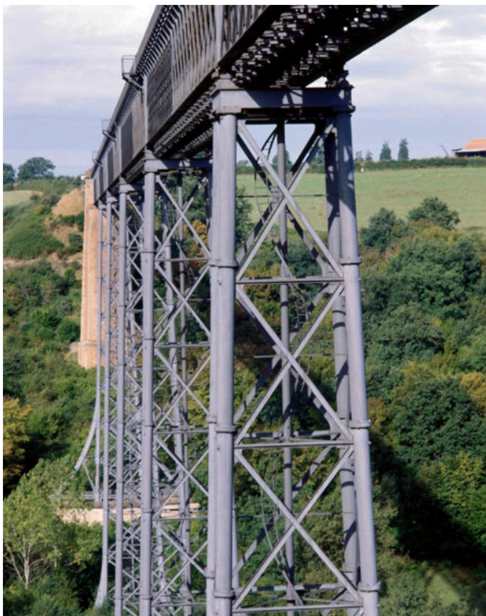
Détail des piles et du tablier métalliques du viaduc.
