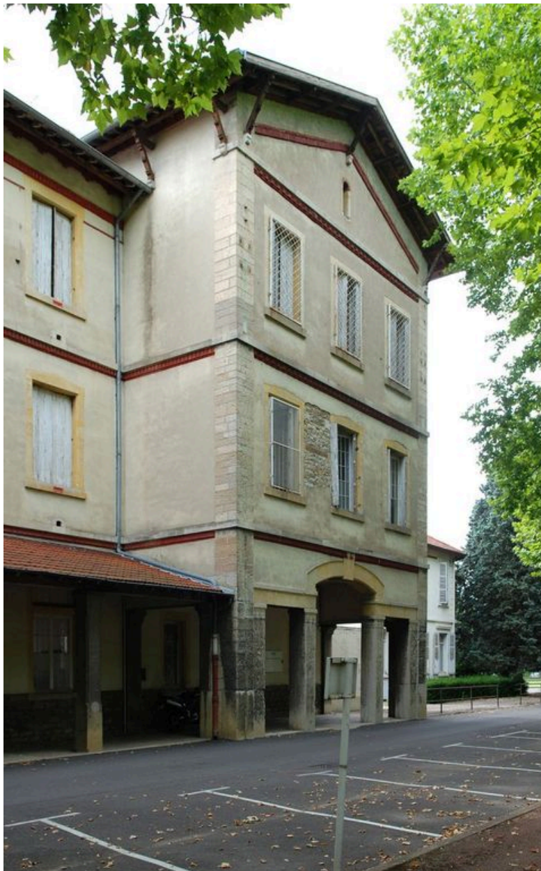
Façade principale, avant-corps latéral sud
