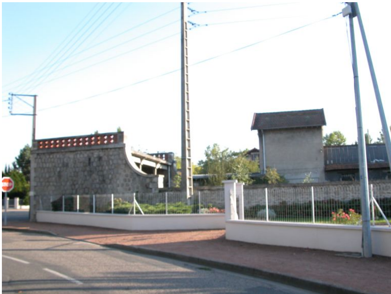
Vue de trois quarts latérale droit du pavillon d'entrée.
