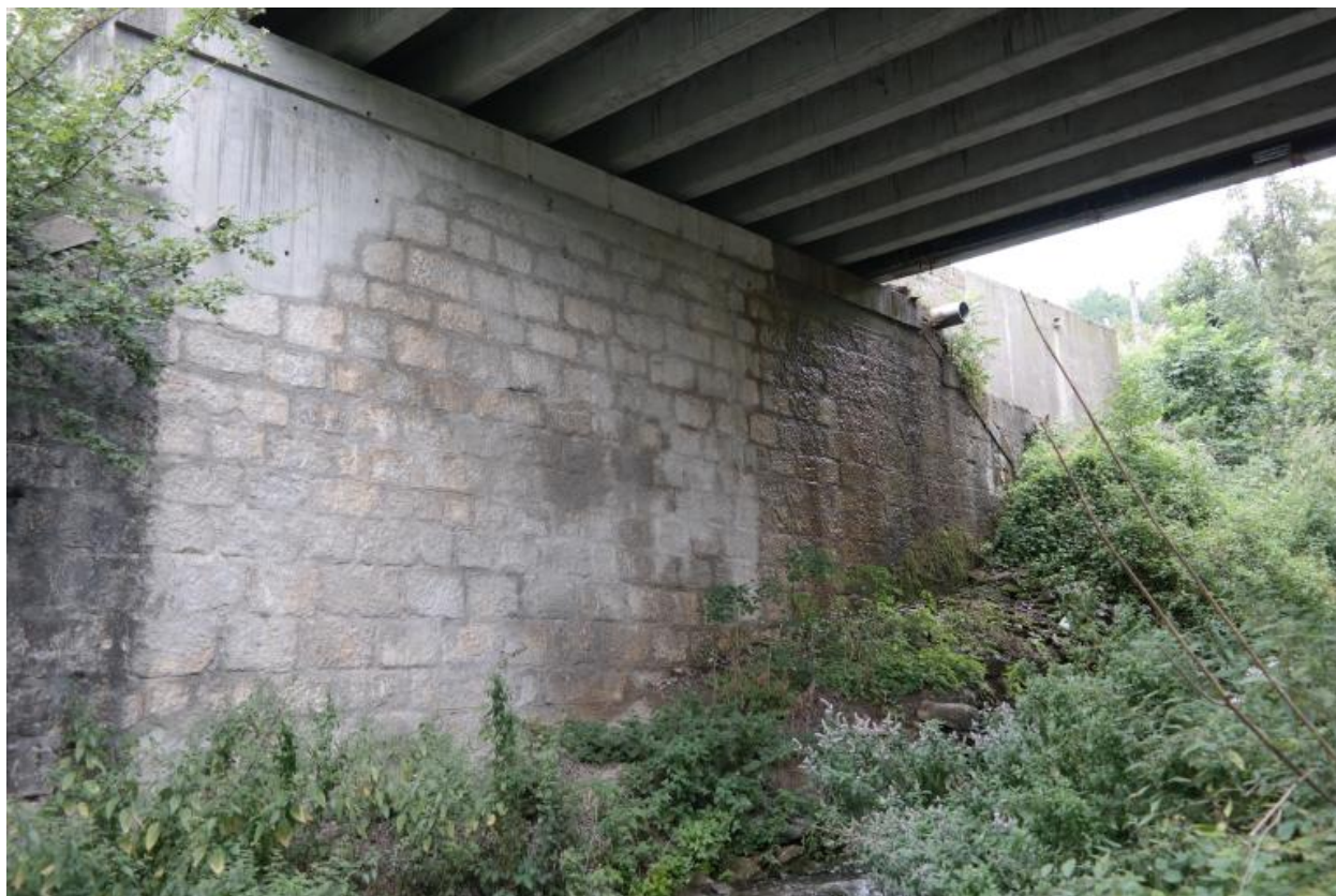
Pont d'Arce, vue de dessous
