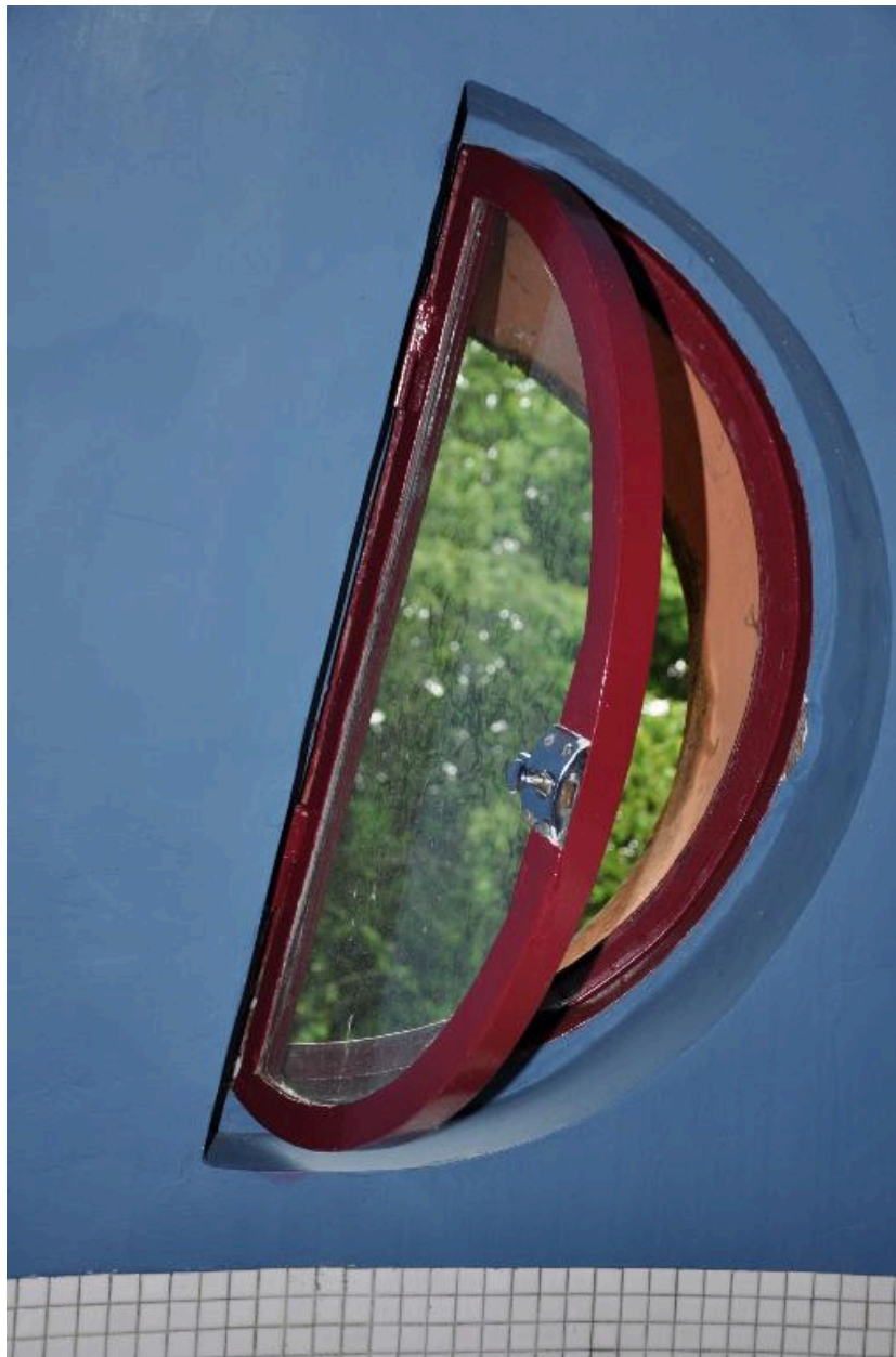
Détail sur une petite ouverture de la salle de bains des chambres du niveau supérieur
