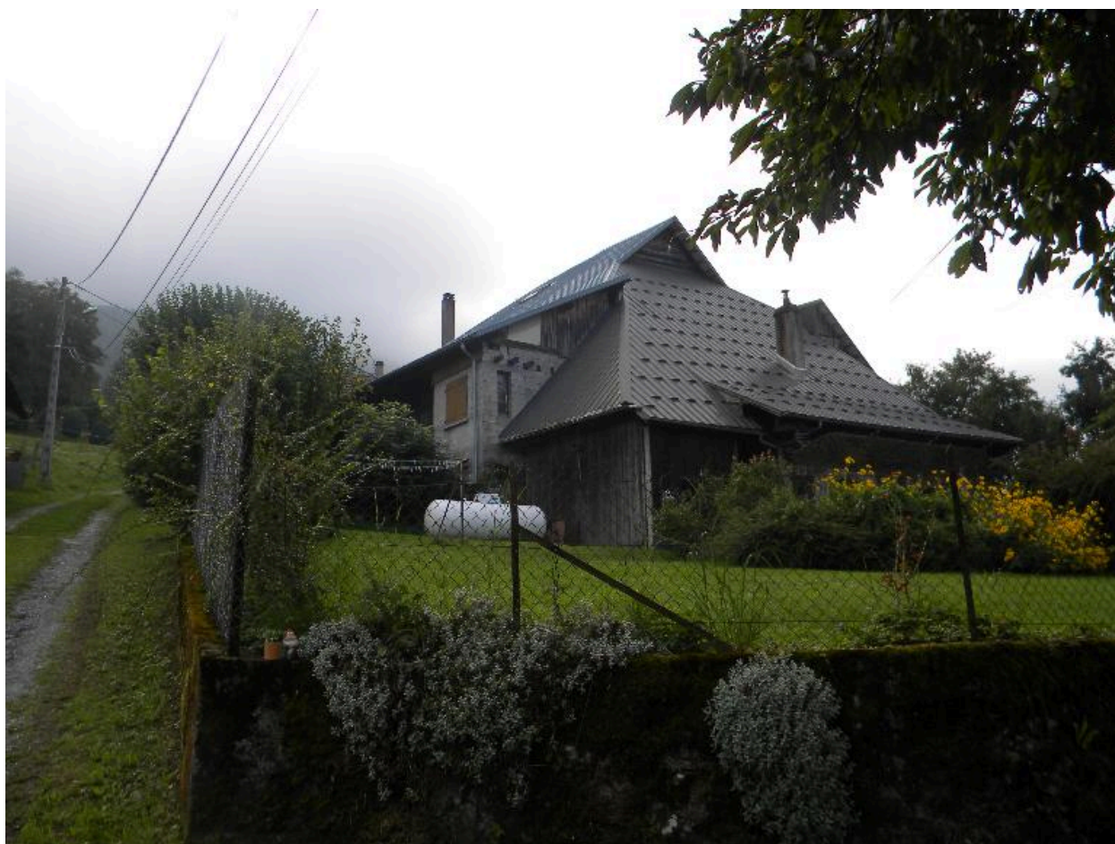
Vue d'une ancienne ferme modifiée (2008 E8 2198).
