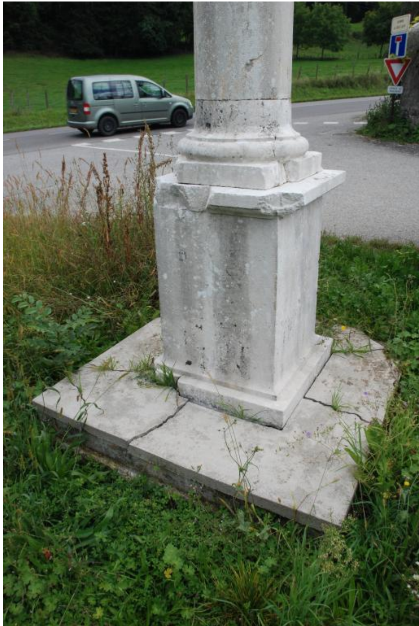
Détail arrière du piédestal de la croix.
