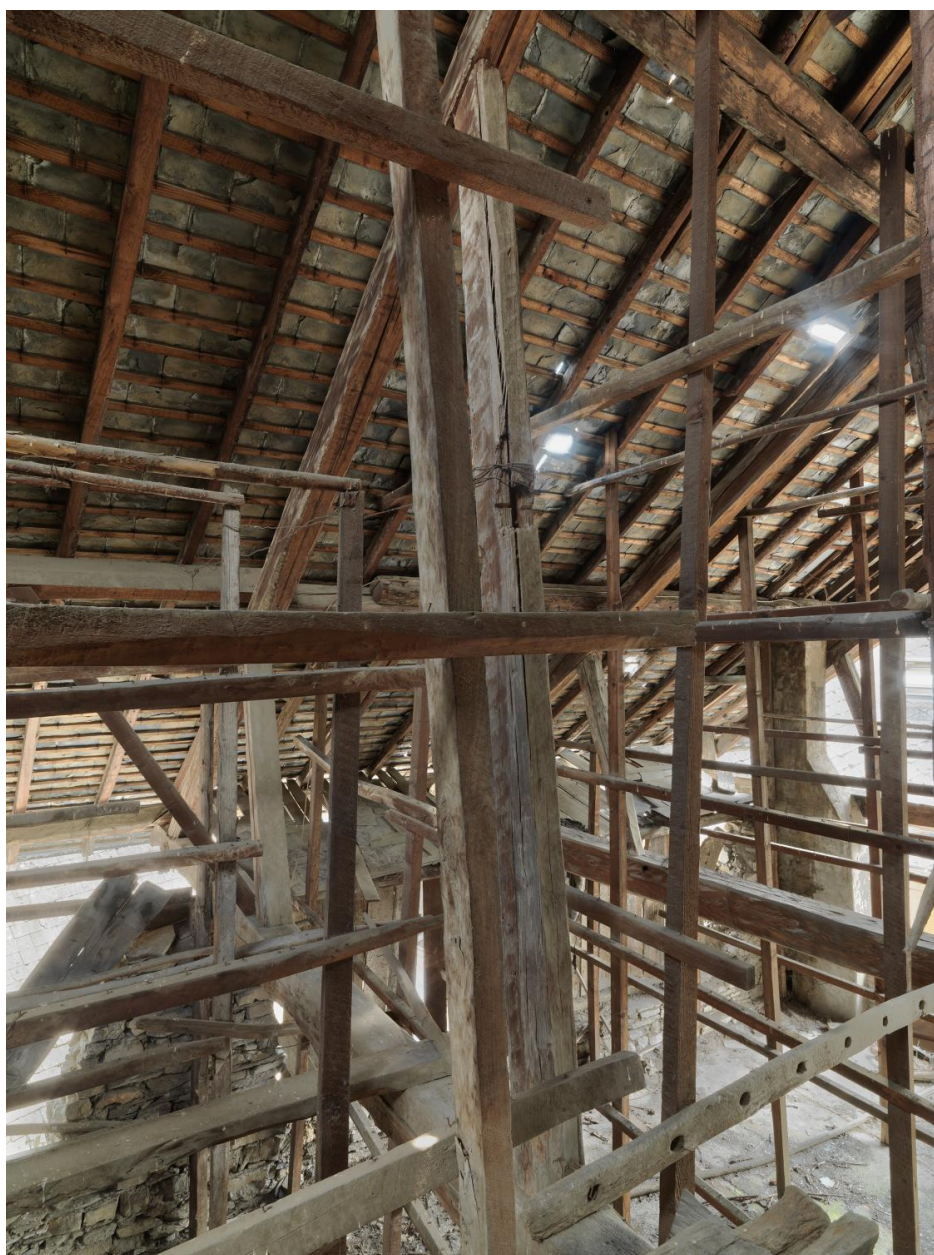
Vue intérieure du comble : perches à tabac.
