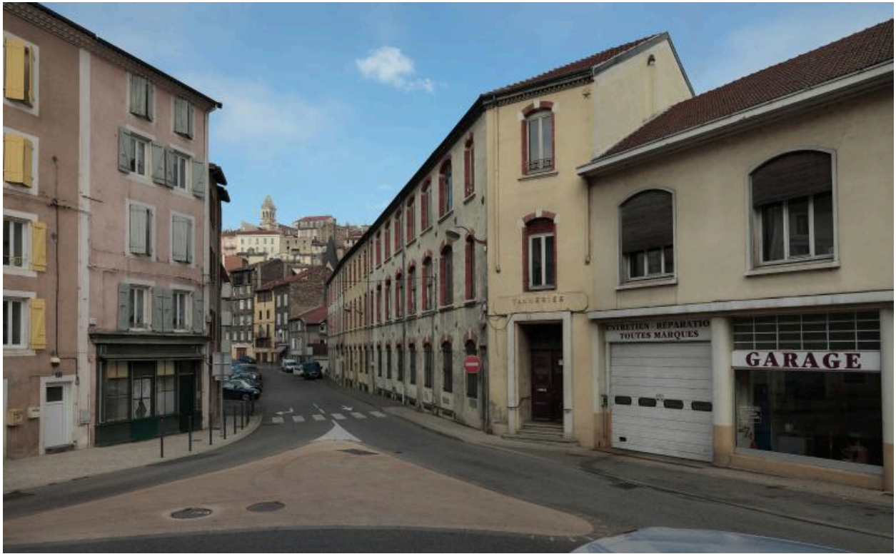
Partie de la tannerie le long de la rue Eugène Meyzonnier.
