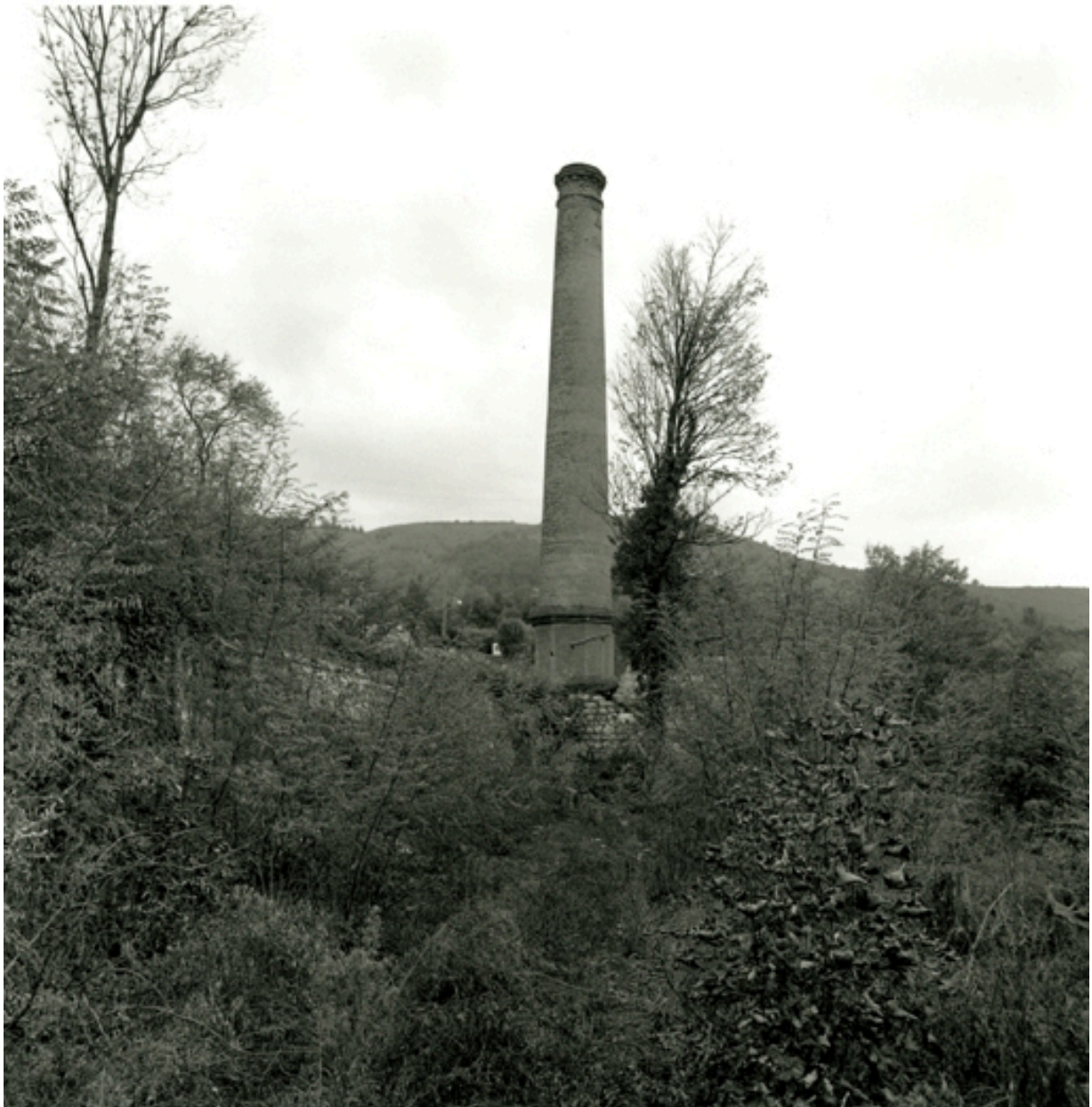
Cheminée en brique
