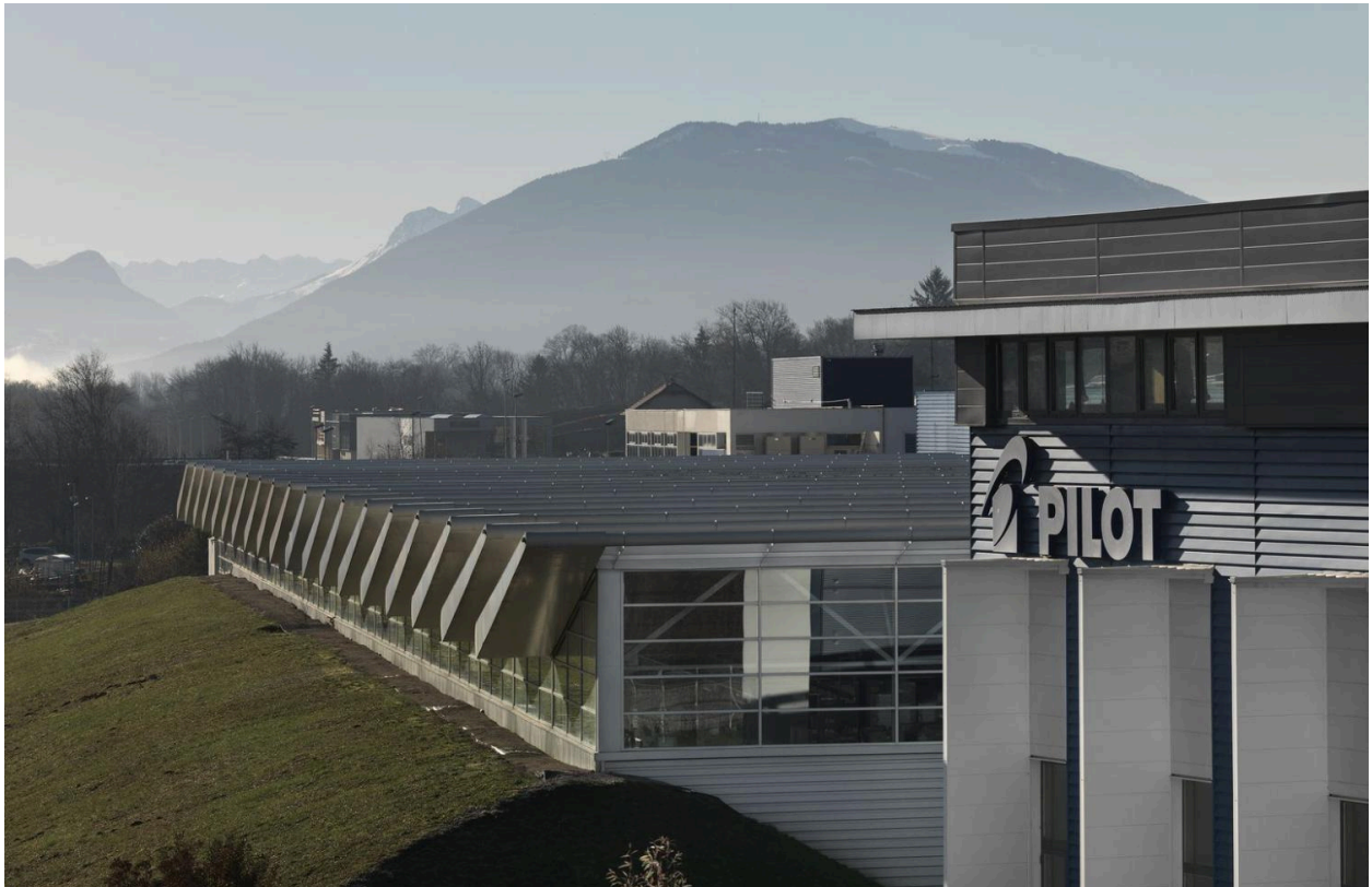
Vue d'ensemble nord de l'usine Pilot
