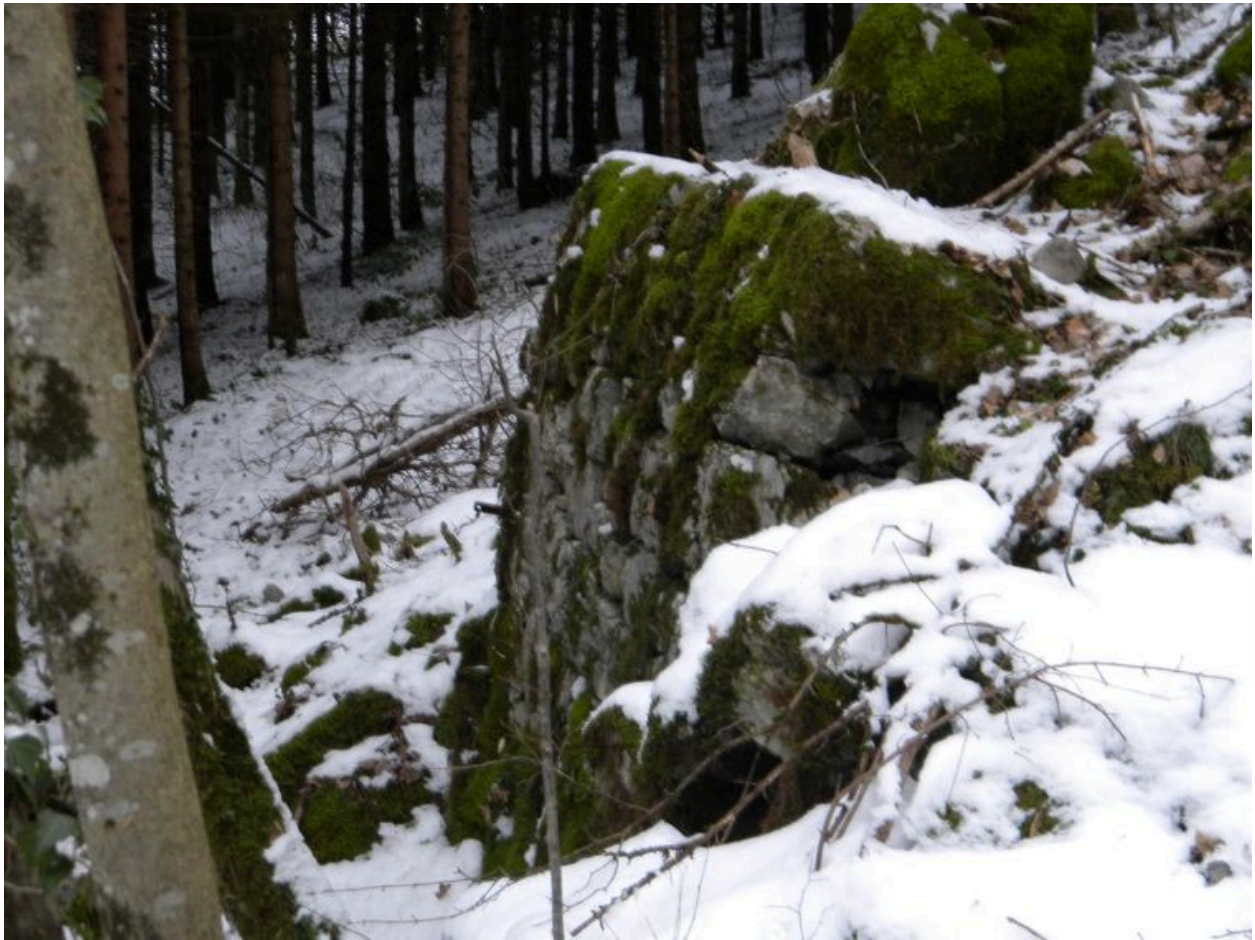
Mur de soutènement d'un ancien chemin dans les vignes (2008 A10 1842).
