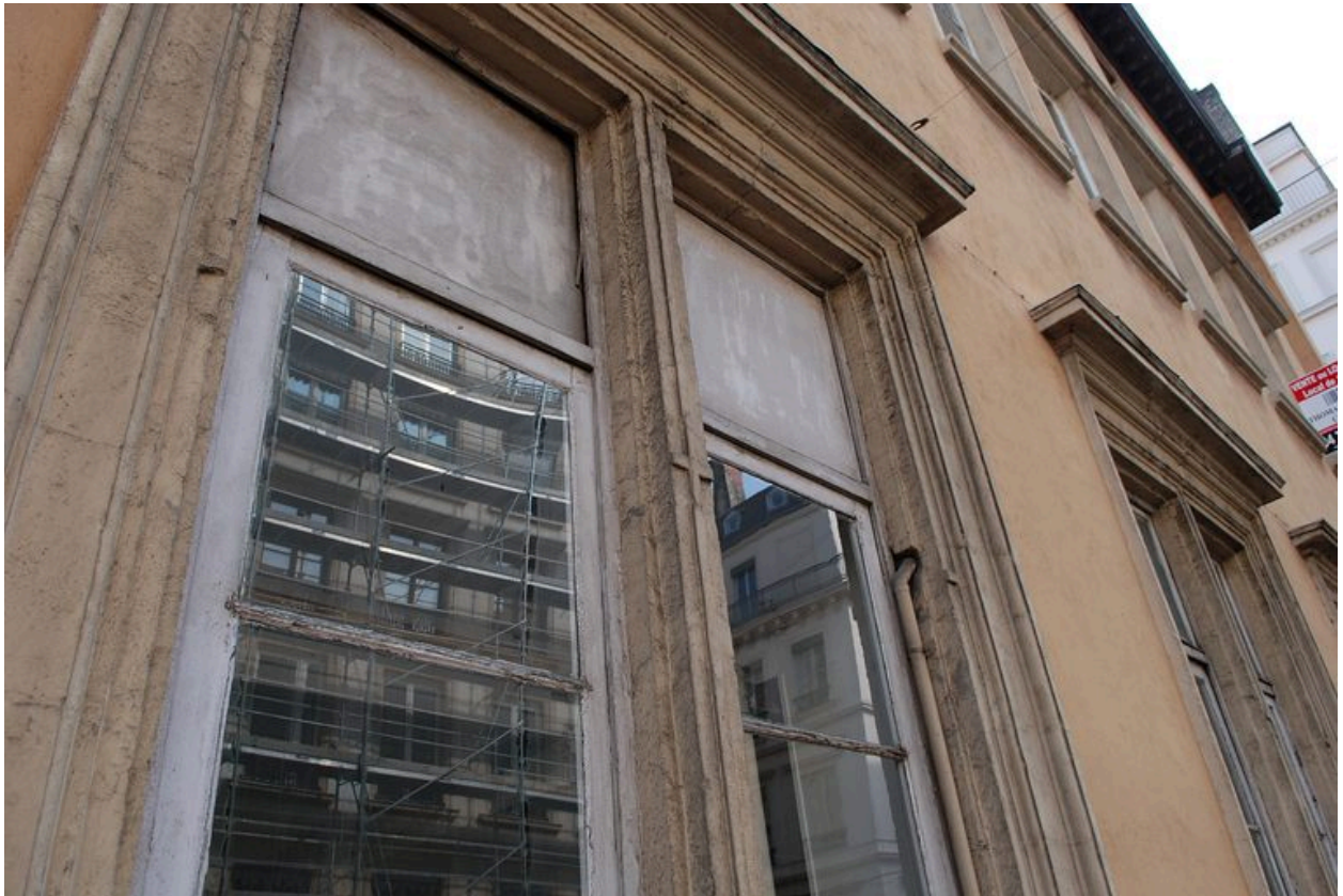
Elévation ouest : 1 étage carré, ancienne fenêtre à meneaux
