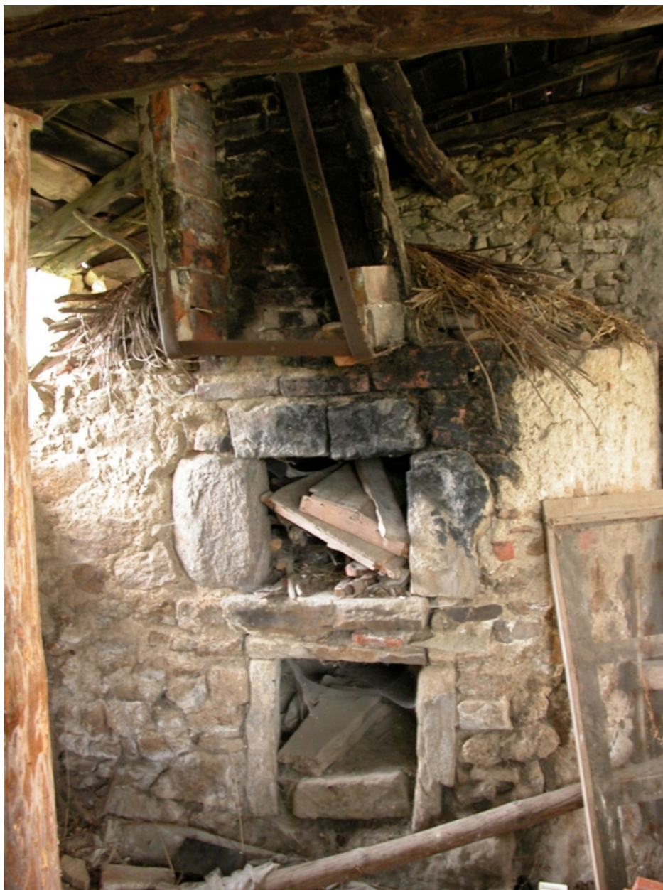
Bouche du four à pain.
