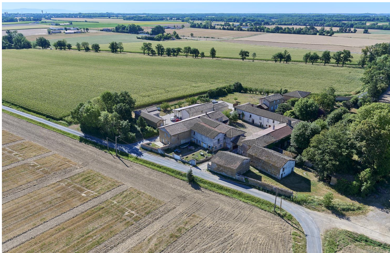
Vue aérienne, depuis le nord
