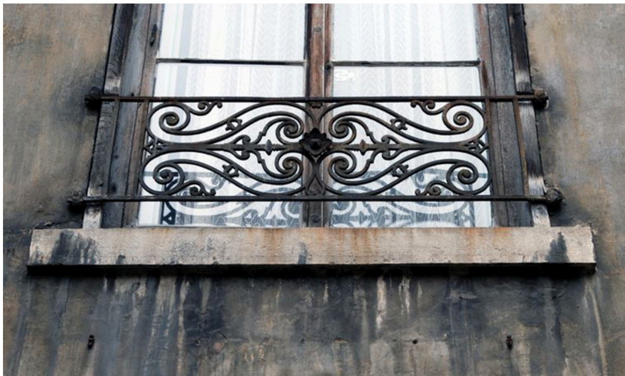
Elévation postérieure, détail de garde-corps
