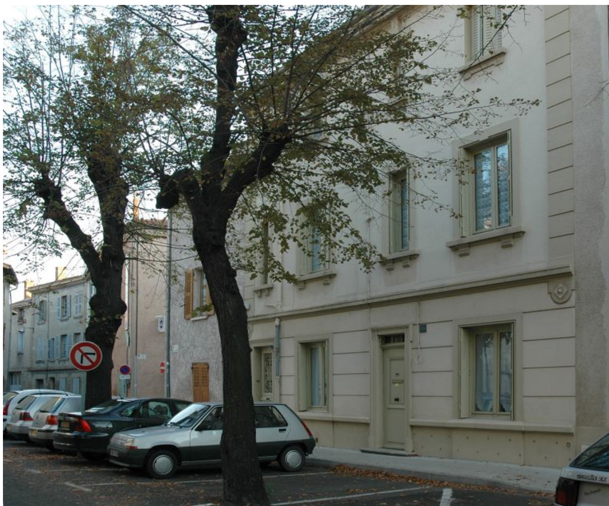
Vue générale sur rue
