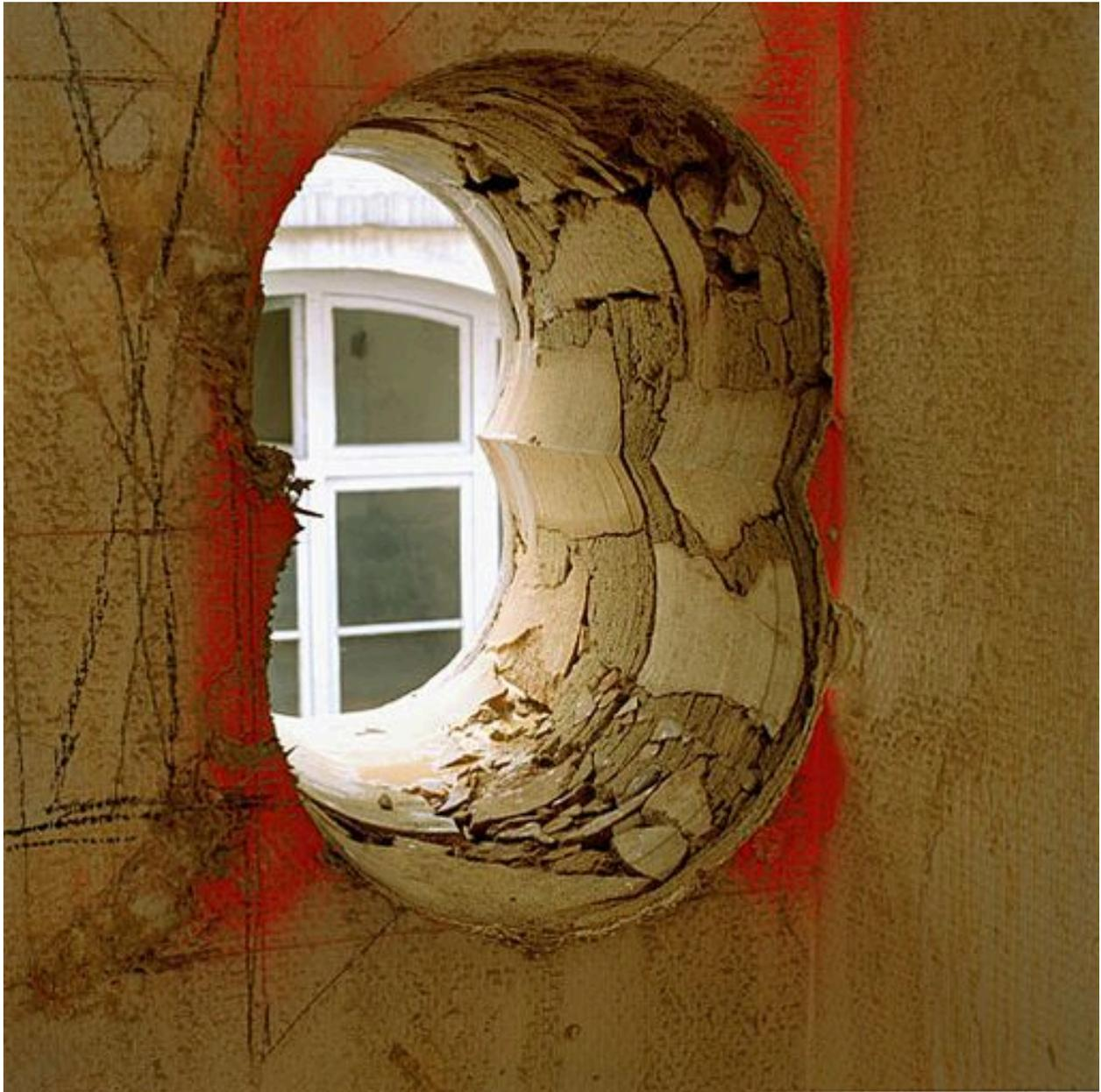
Corps sur la rue Mulet, façade sur cour, détail d'un carottage du mur vu de l'intérieur au 2e étage, montrant un blocage entre 2 parements de moellon
