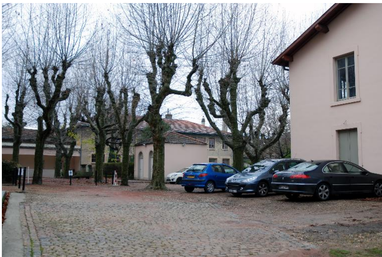
Cour ouest, depuis le nord-est
