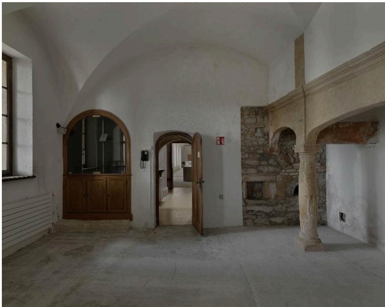
Ancienne cuisine au rez-de-chaussée : vue de l'ouest
