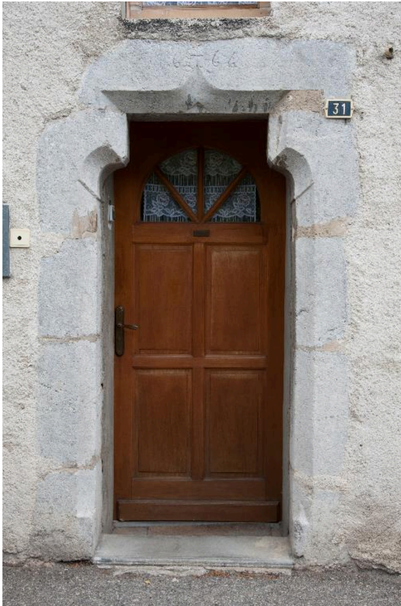
Vue d'un encadrement chanfreiné avec piédroits à congés et linteau en accolade sur coussinets
