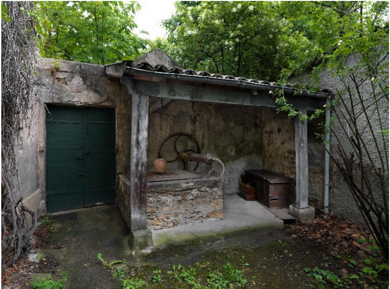
Vue du puits couvert, dans la cour
