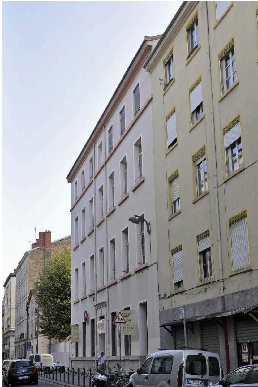
Bâtiment sur rue, élévation antérieure
