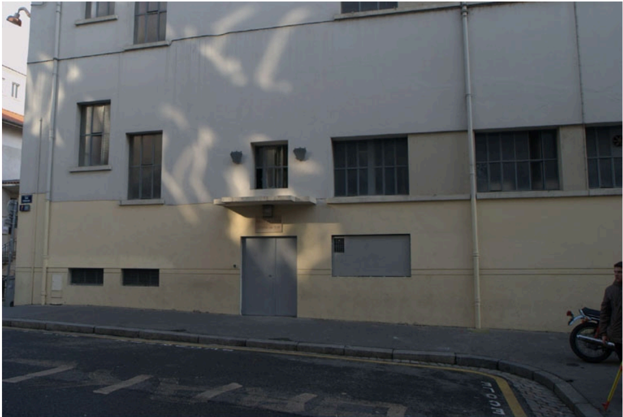
Façade nord impasse Flesselle
