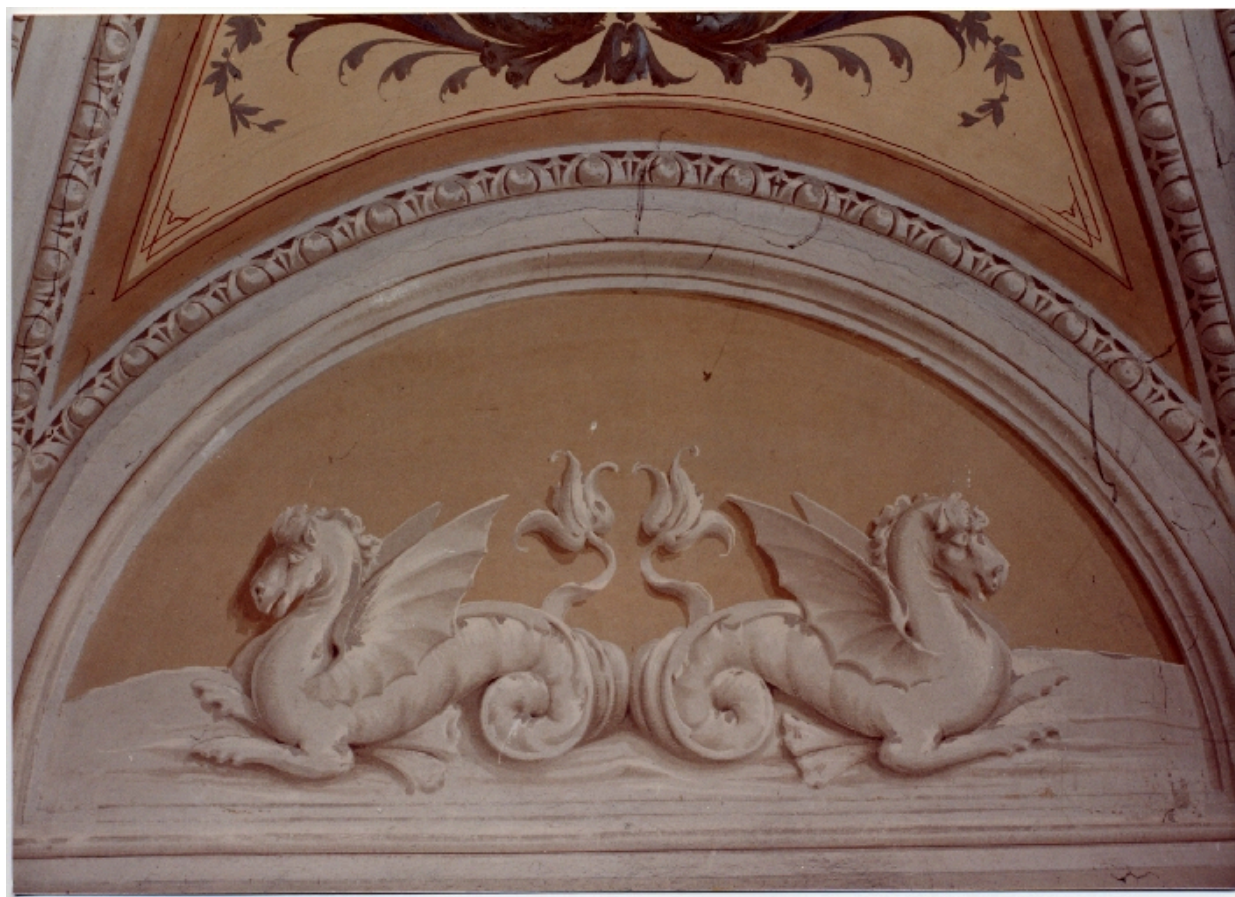
Décor de la voûte du hall, détail
