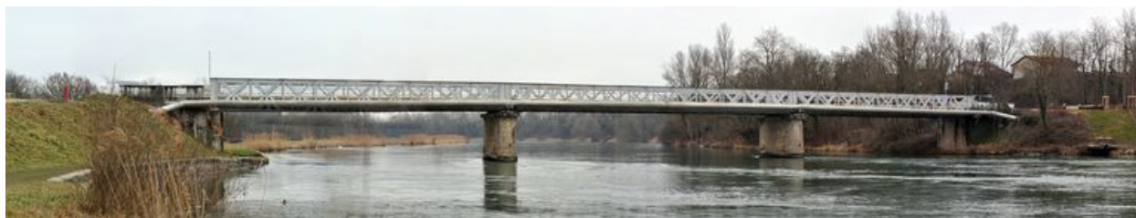
Vue panoramique, face aval (depuis le rive droite)
