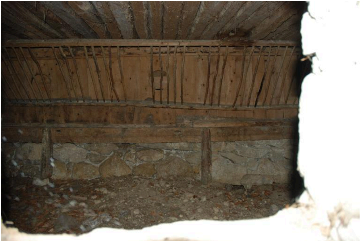
Vue intérieure de l'étable.
