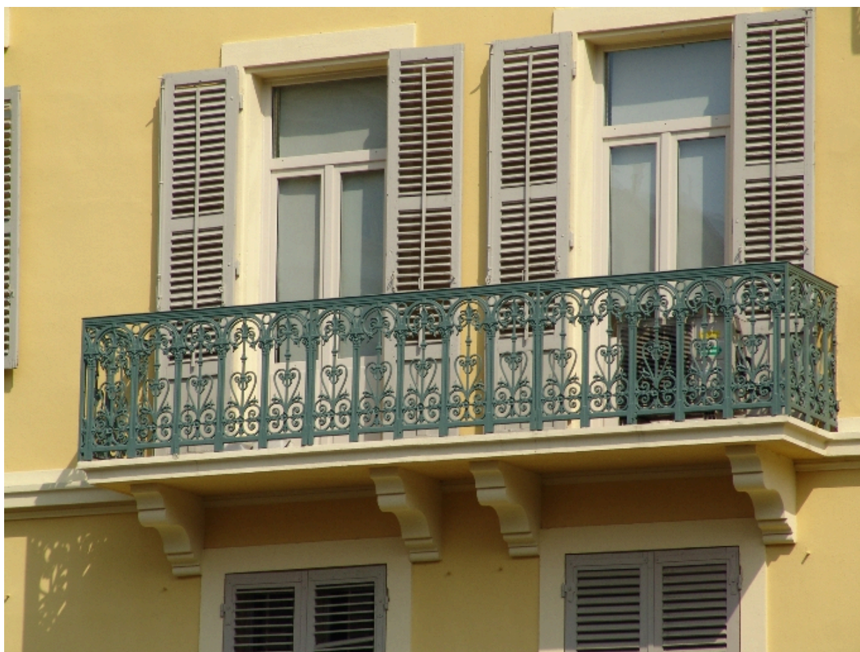
Détail des balcons
