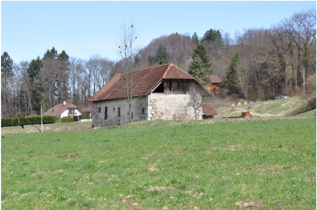
Vue de l'élévation sud-est du moulin
