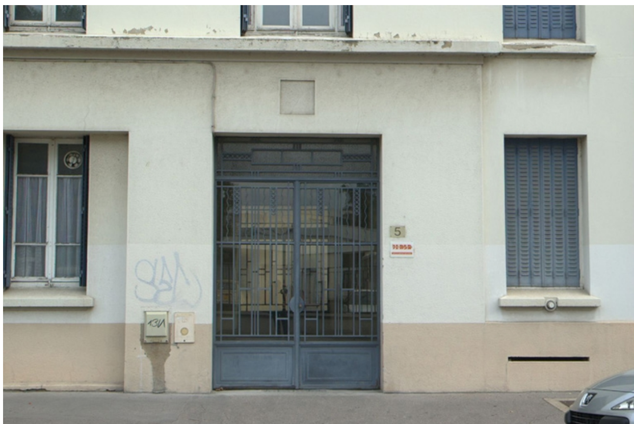
Entrée principale du 5 (entrée de l'immeuble)
