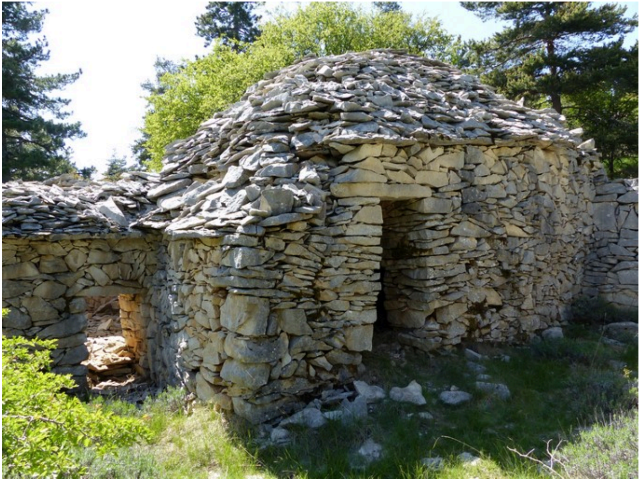
Cabane nord. Vue d'ensemble prise du nord-est.
