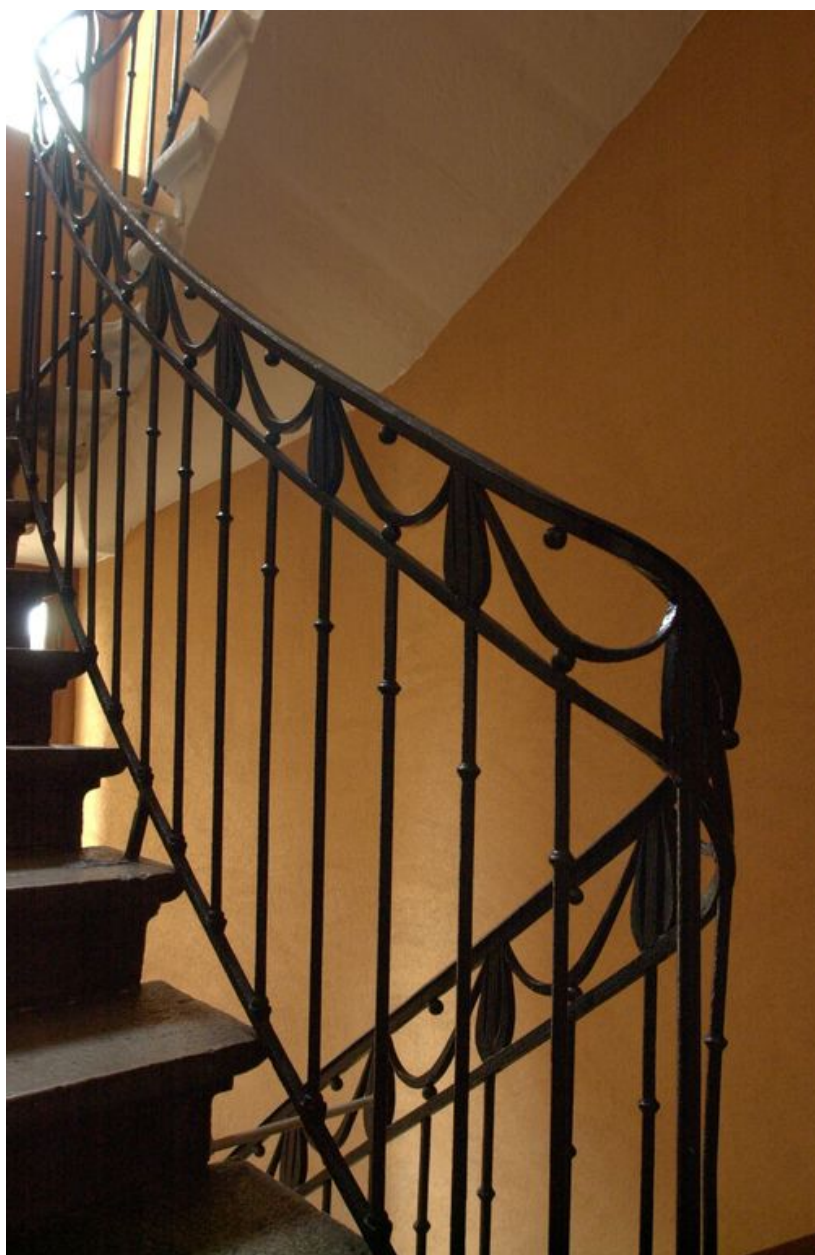
Détail de la rampe d'escalier en fonte
