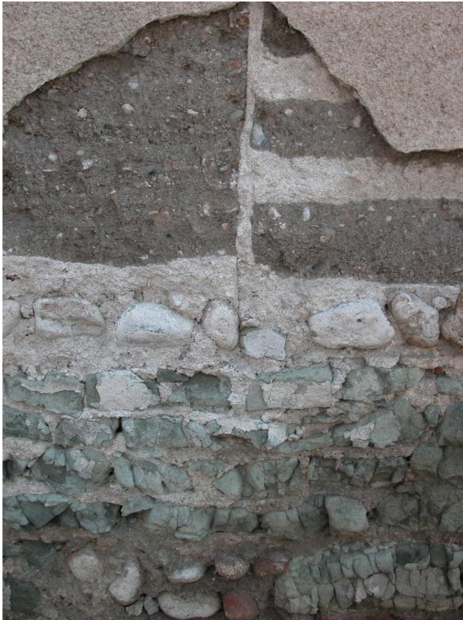
Bourg (le), Mur 1983 B1 79. Détail de mise en œuvre du mur de pisé sur un soubassement constitué de galets.
