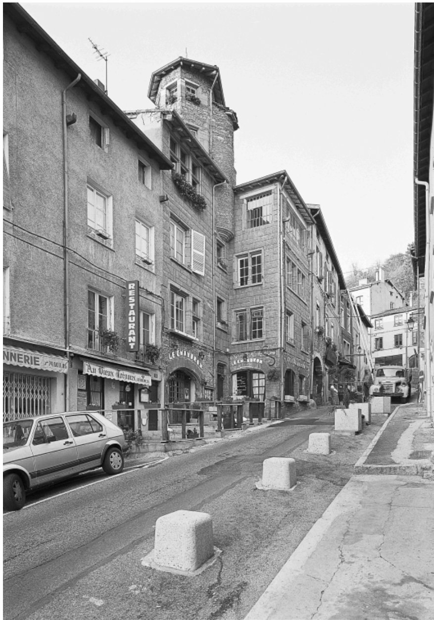
Vue d'ensemble des immeubles 6 et 4 rue du Port
