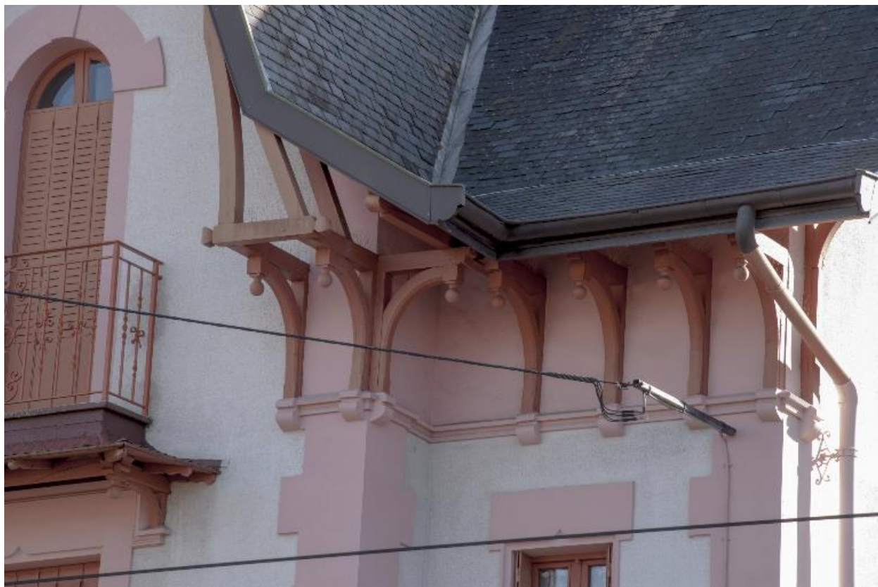
Détail des aisseliers en bois
