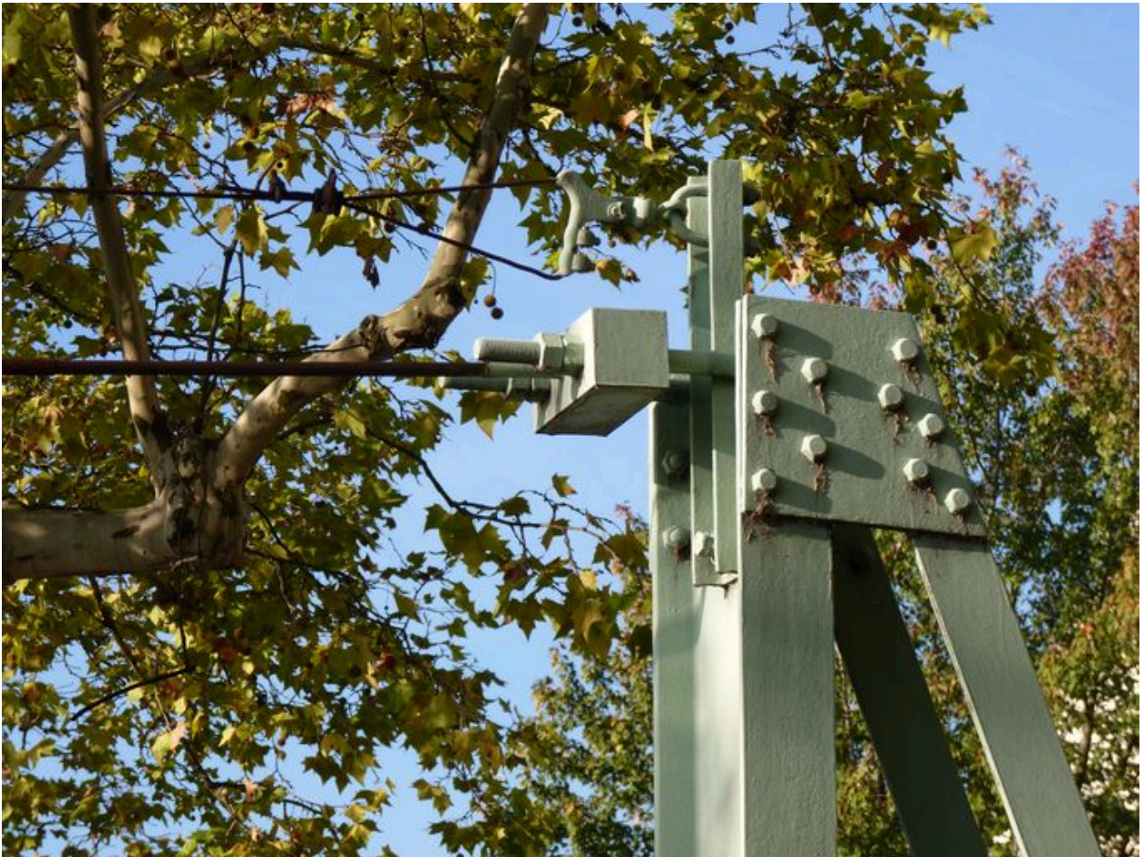
Détail de la structure métallique subsistante en rive droite
