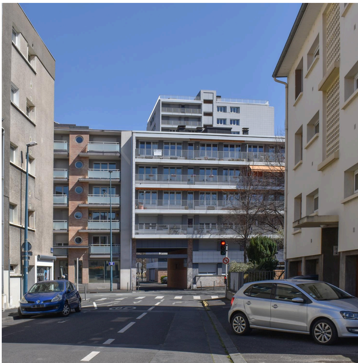
Passage en rez-de-chaussée menant du boulevard Aristide-Briand à la place de Regensburg
