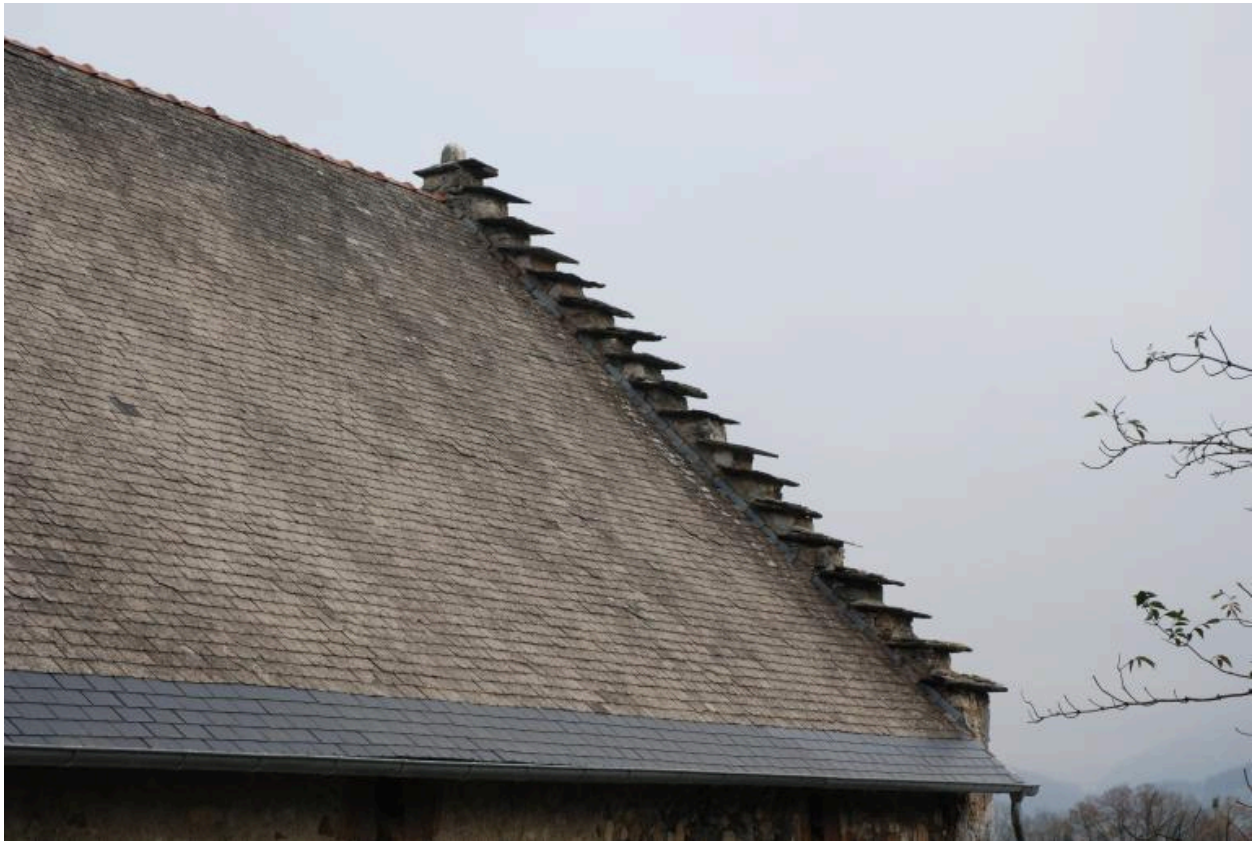
Détail du pignon à redent sud (sud-est).
